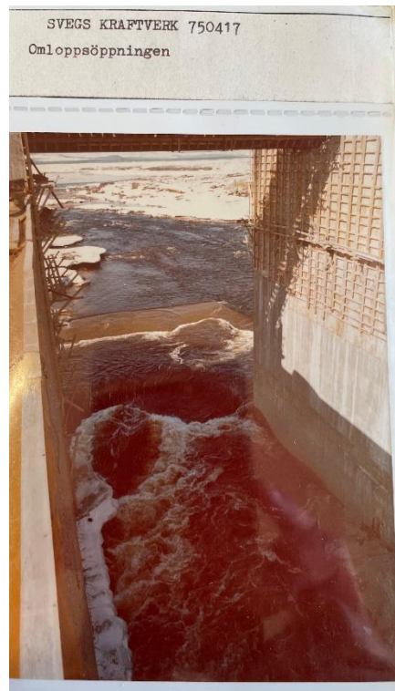
Figur 8: Omloppsöppning (även benämnd omloppsutskov) som användes under byggtiden för att leda älvvatten genom dammen. När bygget av de övriga utskoven var slutfört anlades en valvdamm för att dämna öppningen. Fotot är från 1975-04-17.
