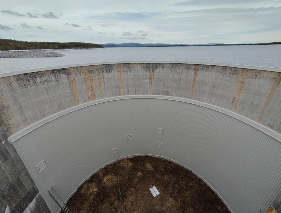
Figur 10: Nedströmsvy av valvdammen.
