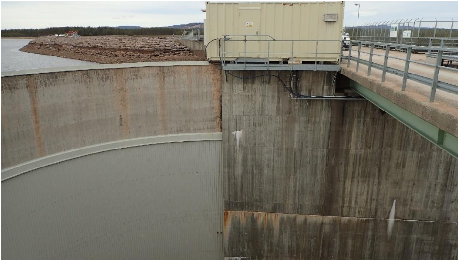
Figur 12 – Bottenutskovens högra pelare som även utgör ett stöd för valvdammen och körbanan över dammkrönet.
