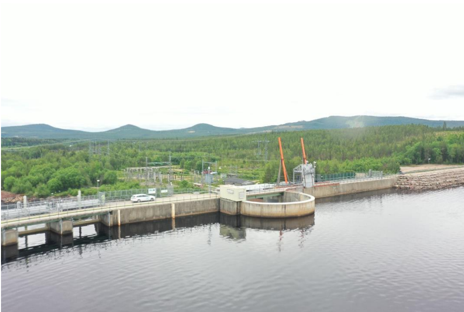
Figur 9: Uppströmsvy av Svegs kraftverks betongdamm. Bottenutskoven är placerade till vänster om valvdammen och kraftstationen är placerad till höger om valvdammen.
