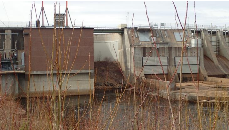
Figur 11 – Nedströmsvy av Svegs dammanläggning. Valvdammen är placerad mellan kraftstationen (till vänster i bilden) och bottenutskoven (till höger i bilden). Det finns en bro nedströms valvdammen som utgör en del av körbanan över dammanläggningens krön.
