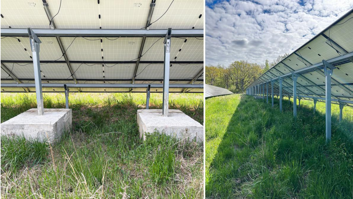
Figur 10. Till vänster illustreras ett markstativ som förankrats med utanpåliggande betongfundament och till höger ett som förankrats genom pålning ner i marken (Foto: EnergiEngagemang, Strängnäs Solcellspark)
