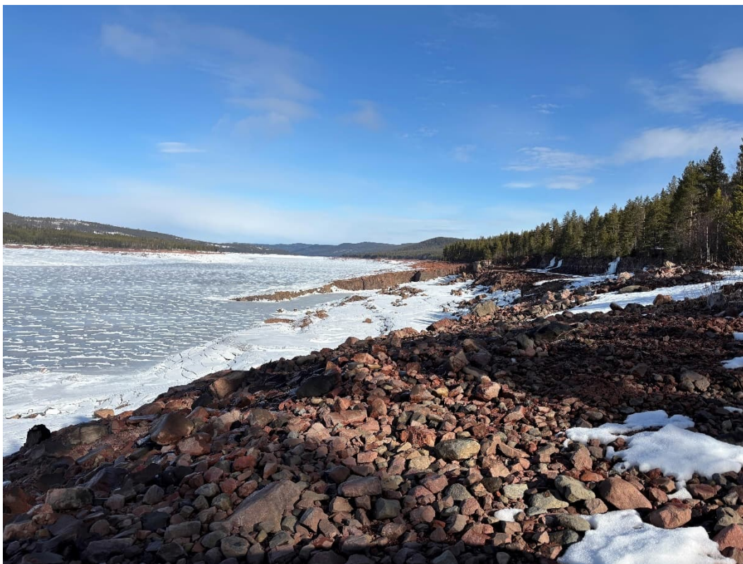
Figur 11. Foto som visar Trängsletmagasinet vid avsänkt nivå.
