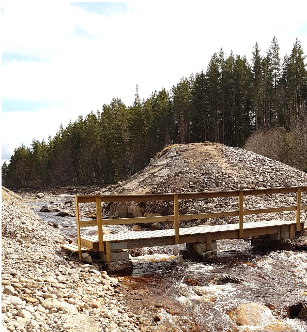
Foto 9 Utloppsälven nu iordningställd med bro och sten, strax efter vårfloden den 30 april 2018, Sjöns nivå var då c:a 185,7 m.ö.h. i mätsystemet RH 2000 vilket är den nivå som bedöms som "normal".
