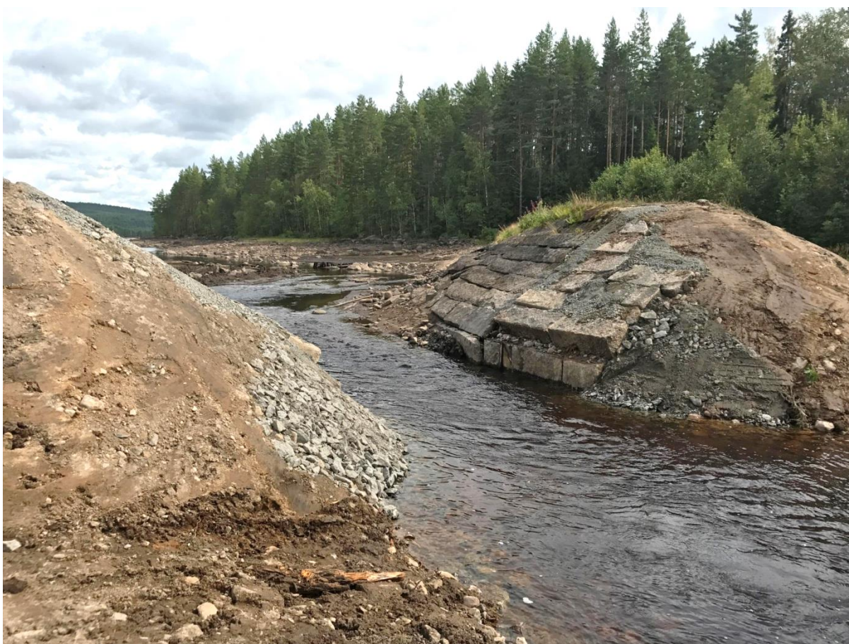
Foto 8 Acksjödammen under utrivningsarbetet 2017-08-08 Foto Norconsult
