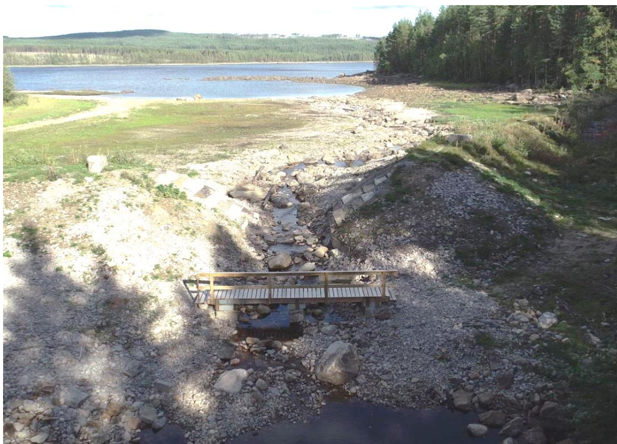
Foto 11 Acksjöns utloppsvik 1 år efter utrivning 2018-09-13. Extremt lite vatten i Acksjöälven vatten. Foto Norconsult
