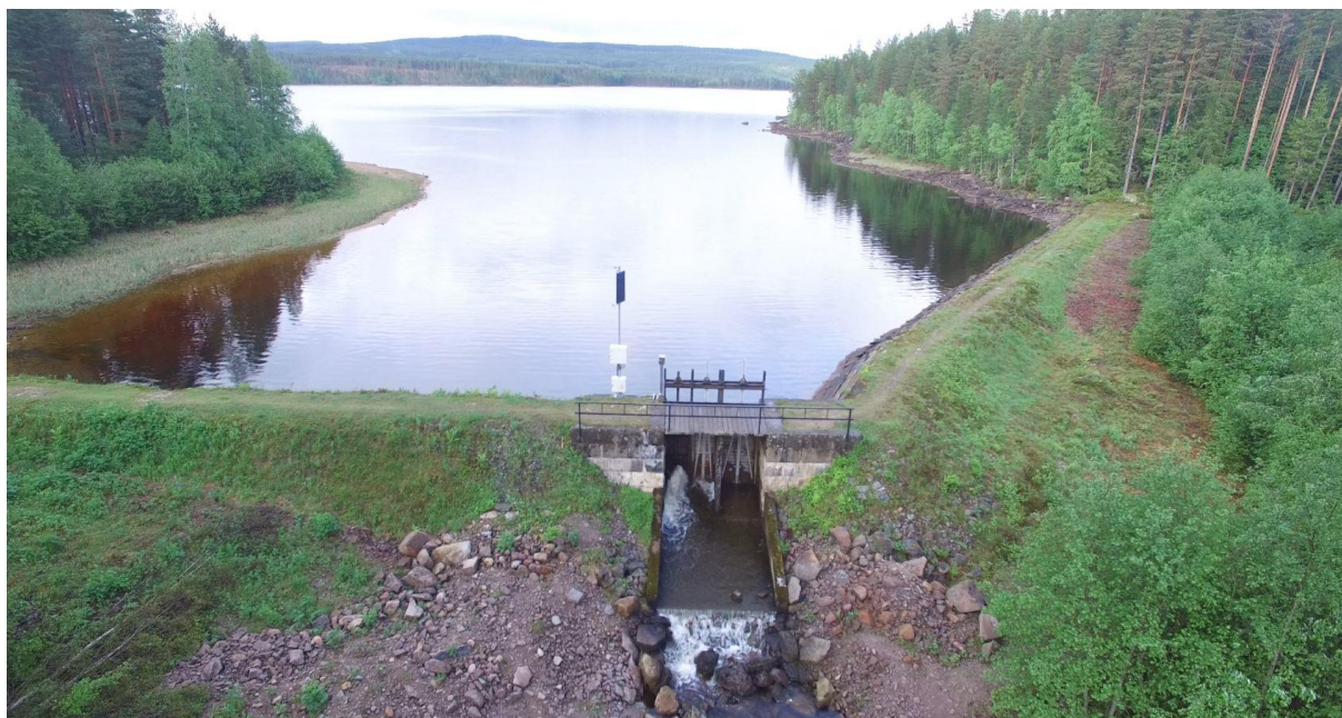
Foto 10 Utloppsviken fotad mot dammen: Acksjödammen före utrivning, foto Axel Emanuelsson, Norconsult
