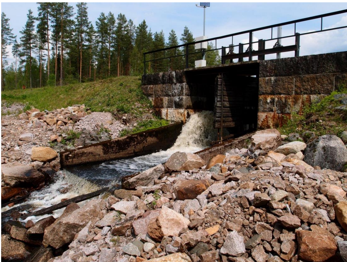
Foto 7 Acksjödammen före utrivning2013. Foto A. Sjörs
